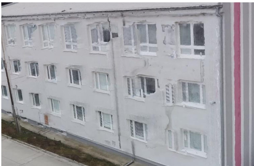
Obrázok 8: RealityCapture, 436 fotografií, zjednodušený a textúrovaný model, zameranie sa na chybu Zdroj: vlastné spracovanie.
